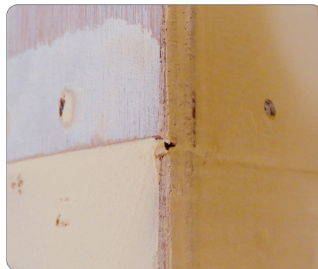
合板での施工
