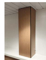
ダクトカバー
