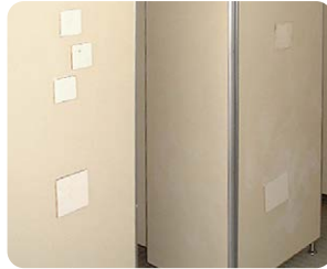
壊れやすく穴が空いてしまったトイレブースの補修例
